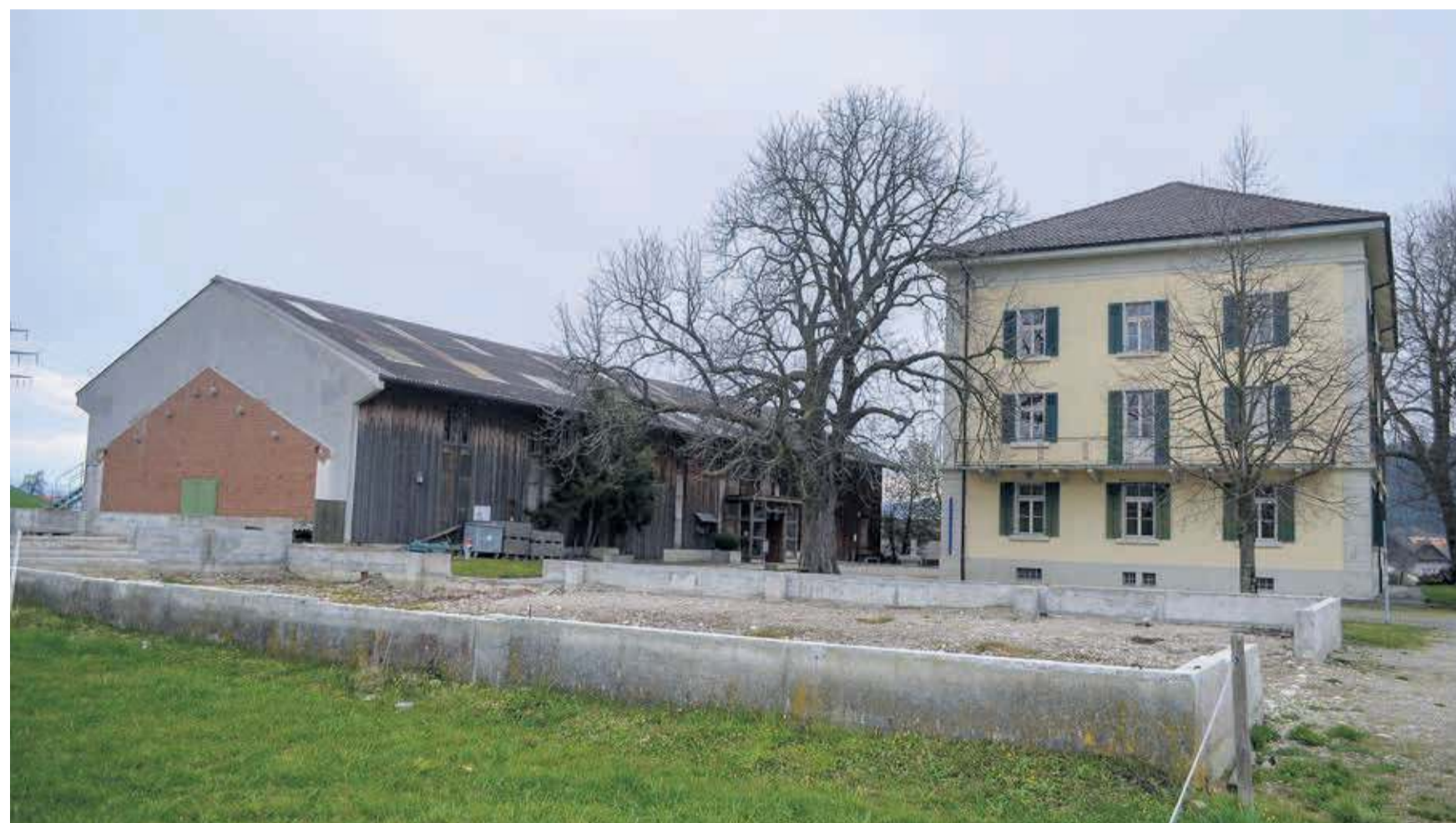
Die Baufreigabe auf Burgrain ist erteilt: Im April wird neben dem Agrarmuseum und der Remise die «Schüür» gebaut. Foto Stephan Weber
